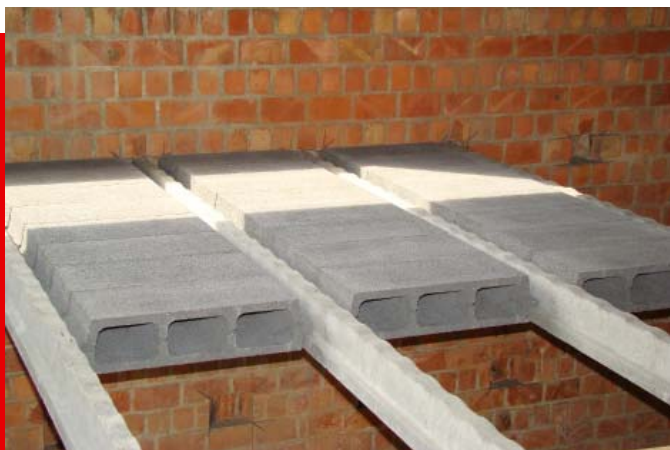
> Výměna stropu za strop RECTOBETON
