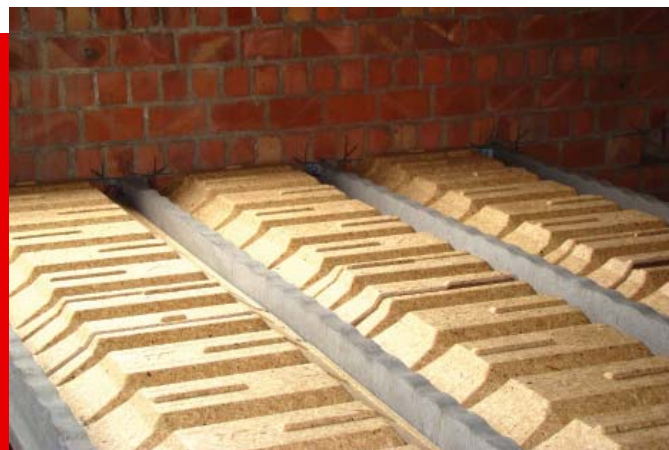
> Výměna stropu za strop RECTOLIGHT
